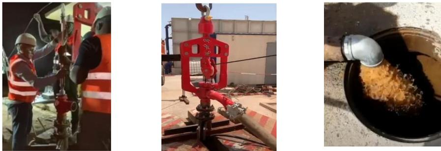
**Figura 3:** Muestra la introducción del generador en el interior de la tubería de airlift, junto con el cabezal de descarga y la extracción del material incrustado.
