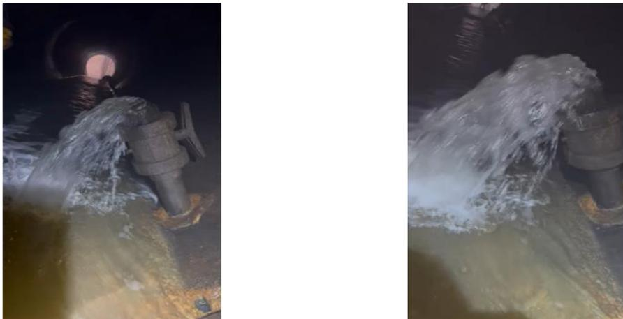
**Figura 9:** Efecto de la aplicación de pulsos en drenes sub-verticales en el interior de un túnel.
